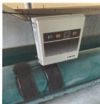
ウォーター アース ロボの設置現場
